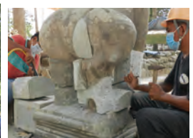
↑技術と根気を要するシンハ彫像の修理と新材加工。
