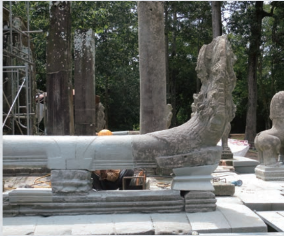
上は修復前のナーガ像。カンボジアの人々による、地道な作業を経て、修復が終了した(下写真)。
