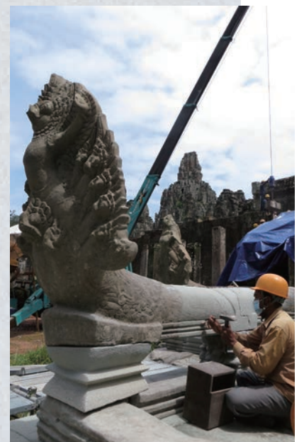
仮組作業後、新材で補填した部分の仕上げや安定化のための微調整などを行い、修復作業の完了となる。
