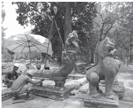
ナーガ像、シンハ像の修復作業
